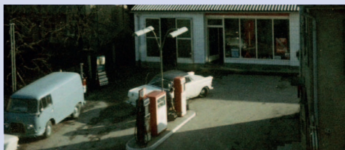
Esso-Tankstelle von Wilhelm Ansel in der Münchinger Straße 24/26 (1967)
