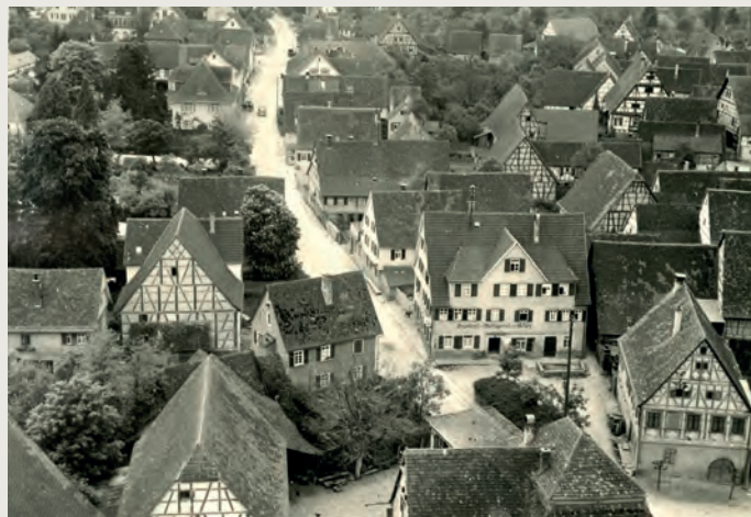
Blick in die Leonberger Straße. Bis Mitte des 19. Jhds. war mit Ausnahme von Kelter/Schafhaus nur der vordere Bereich etwa bis zum Bahnhofsgässle (Wilhelmstraße) bebaut; dahinter begann die Feldflur.
