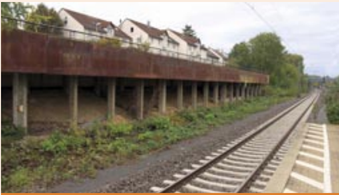
Die alte Laderampe in Ditzingen (Foto: Wilfried Weber)
