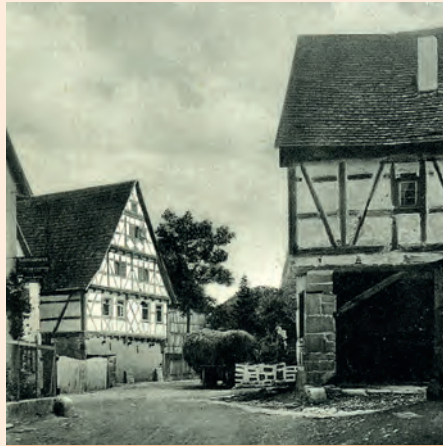
Alte Schmiede Mittlere Str. Ditzingen
