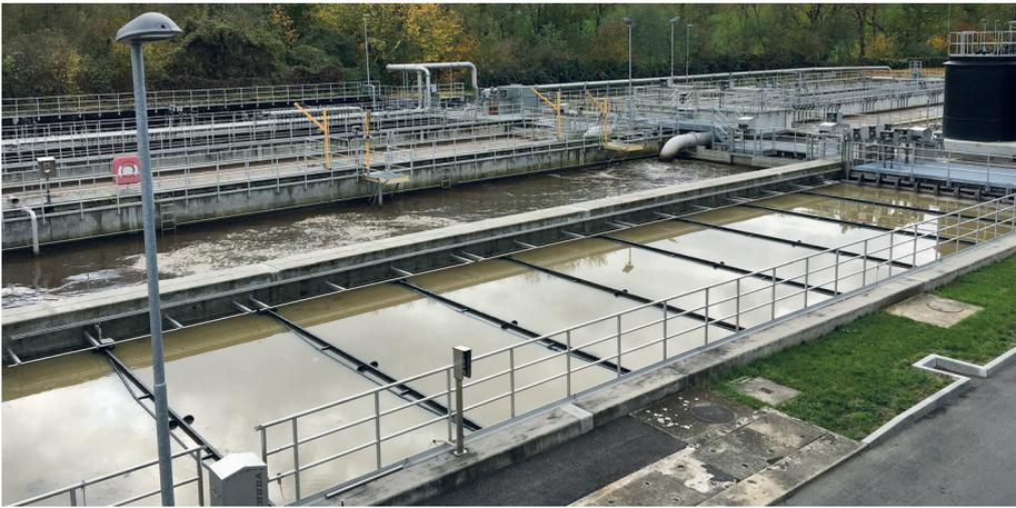
In den Nachklärbecken wird nun das gereinigte Wasser von Belebtschlamm und Schwimmstoffen getrennt. Der Rücklaufschlammabzug erfolgt kontinuierlich über insgesamt sechs Pumpen (zwei pro Becken). Nach diesen vielen Reinigungsschritten fließt das Wasser dann – sichtbar gut gereinigt – in die Glems. Hat die Glems Hochwasser, so wird der Hochwasserschleier automatisch geschlossen und das Hochwasserpumpwerk aktiviert. Nur so ist ein sicheres Ableiten des gereinigten Abwassers gewährleistet.
