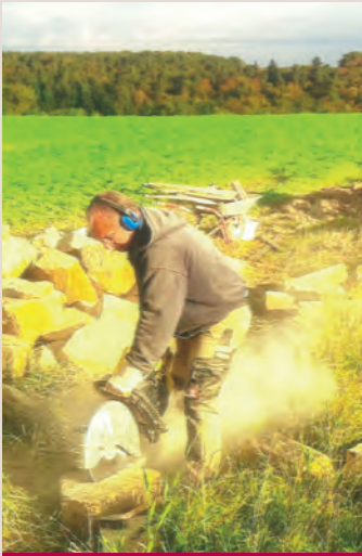
Beim Zuschneiden von Sandsteinen für eine Natursteinmauer für ein Projekt in Schöckingen
